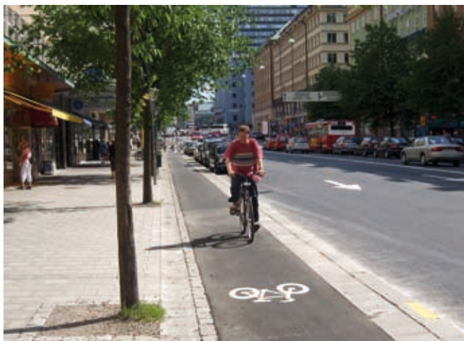
Separering med möbleringszon - ingen nivåskillnad (Sveavägen).
