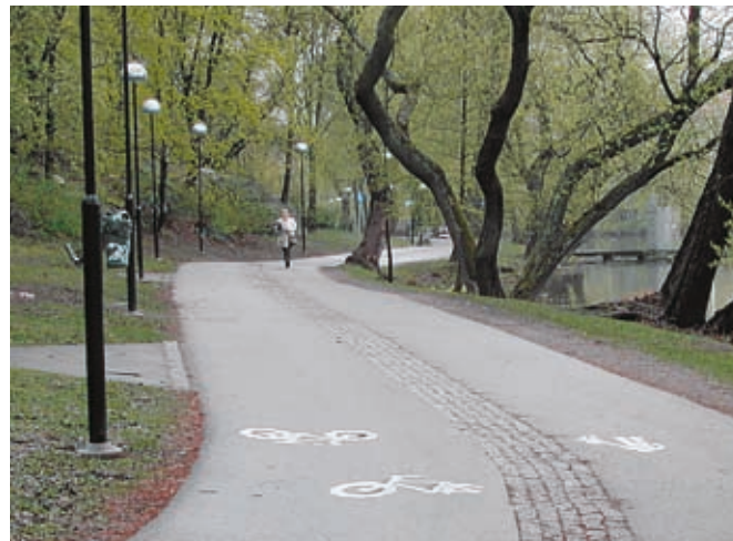
Separering med ränna av smågatsten (Kungsholms Strand).
