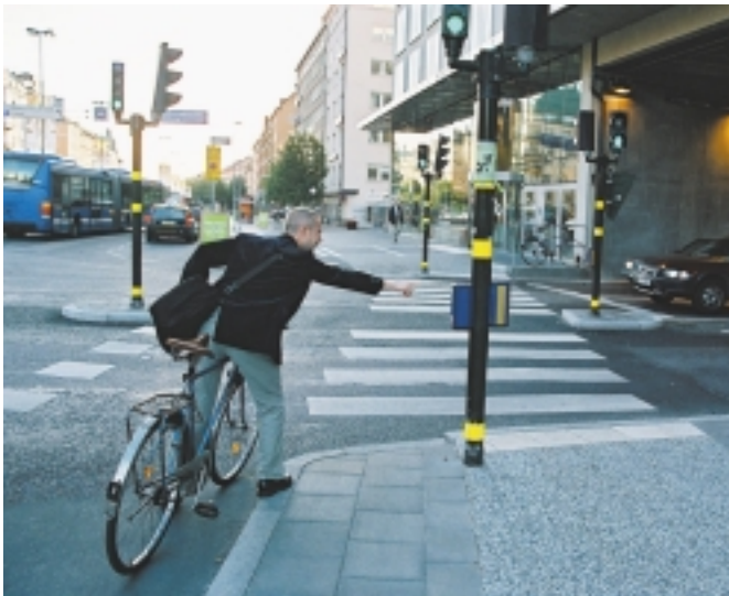
Samma korsning efter ombyggnad. Svårt att nå tryckknappen. Framhjulet sticker dessutom ut i körbanan
