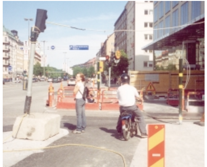
Korsningen Ringvägen - Skansbrogatan under ombyggnad sommaren 2003. Cykelsignalerna nedmonterade, men cykelbanan var öppen
