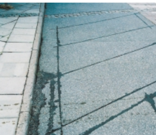
Cykeltillfart med slingdetektering. Dubbla slingor för att känna riktning
