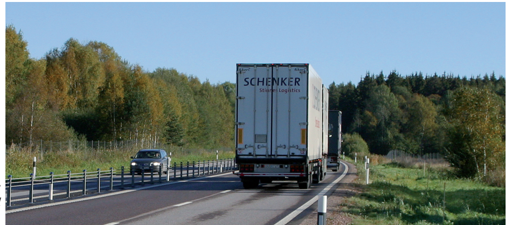
E18 vid Björkås är ombyggd till sk 2+1 väg.
