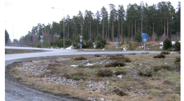
Exempel på hur befintlig vegetation kan etableras i vägmiljöer genom flyttning av hela sjok med markskikt från omgivningen.
