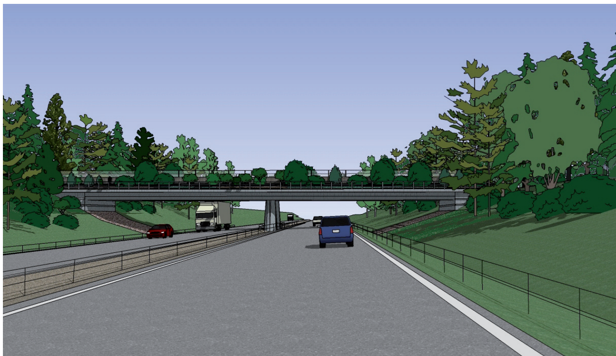
Montaget ovan visar principen för den föreslagna faunapassagen. Läget för faunapassagen har markerats med ett streck på bilden till höger. Ny E18 sänks med ca 3 m vid broläget jämfört med höjdläget för nuvarande väg.
