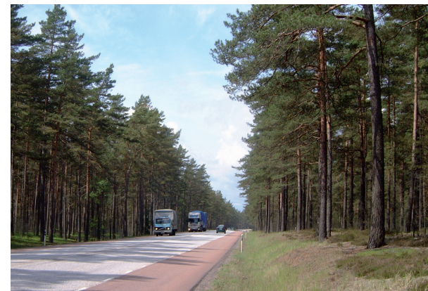
Parti med trädstammar nära vägen i ett vägavsnitt på Sörmon. Genom att viltstängslet är indraget har karaktären av den pelarsalsliknande tallskogen bevarats nära vägen.
