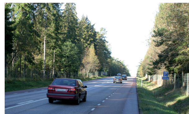
Vägavsnitt där viltstängslet är traditionellt placerat i direkt anslutning till vägdikets bakslänt, vilket medför ett mer tunnellt och avgränsat vägrum.
