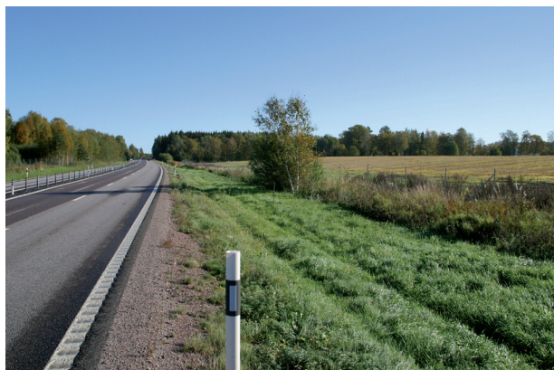
Befintlig E18 vid Björkås. Ny sträckning skär av hörnet till vänster om busken.
