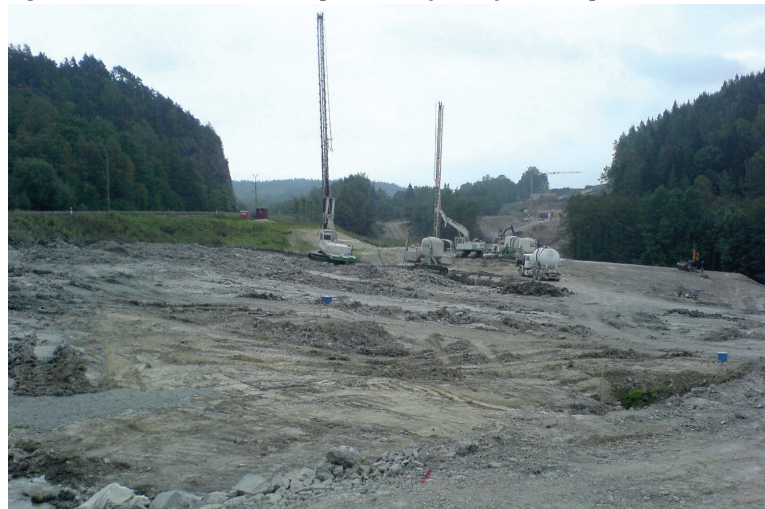
Figur 2.3.4:2 Installation av KC-pelare medför omfattande påverkan.
