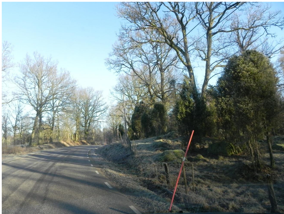
Bild 18. Ekar (till höger i bild) i kurvan norr om Lidhultsån som troligen kommer att behöva fällas när kurvan rätas ut för att få bättre sikt.
