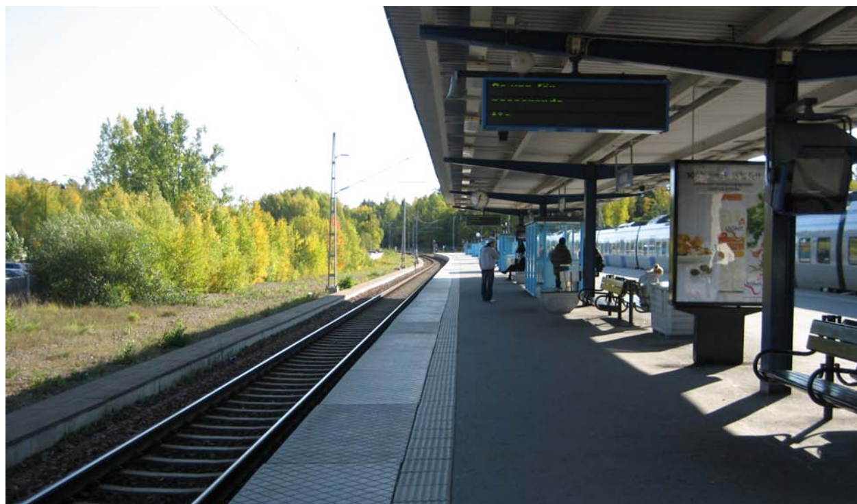
Kallhälls station. Ökad tågtrafik till följd av en utbyggnad av Mälarbanan kommer att innebära ökade partikelemissioner från järnvägen. Miljö kvalitetsnormerna förväntas dock klaras med god marginal vid stationer samtliga i ytläge utmed utredningskorridorerna.
