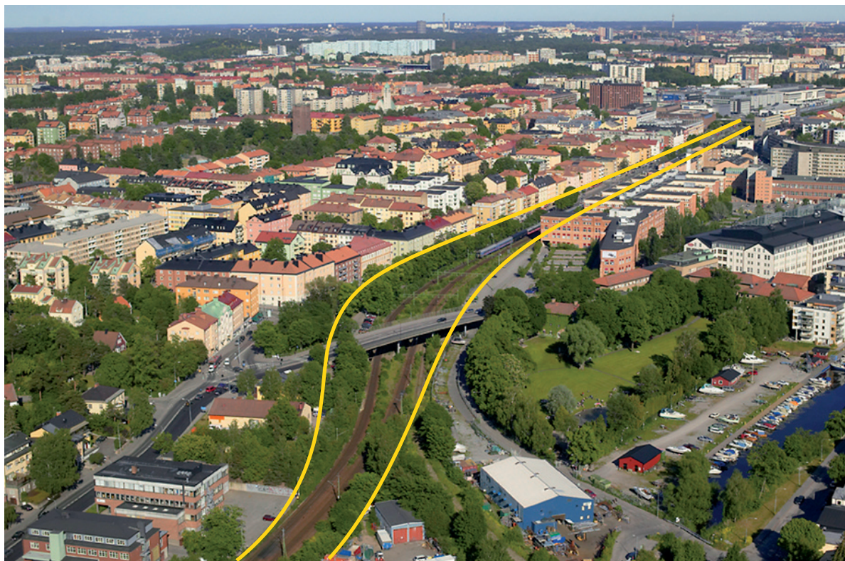
Sundbyberg från väster. En utbyggnad till fyrspar genom Sundbyberg innebär att ortens kulturhistoriska karaktär som stationssamhälle i varierande grad utarmas beroende på alternativ utformning.
