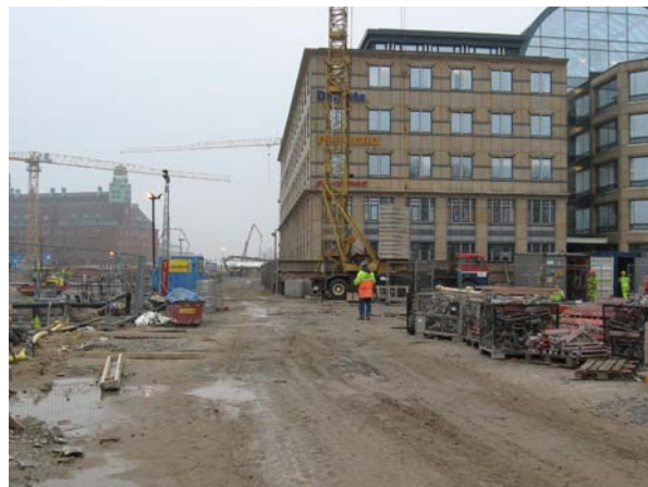
I exempelvis Sundbyberg kommer byggandet att ske i stadsmiljö. (Bild från byggnation av Citytunneln i Malmö).
