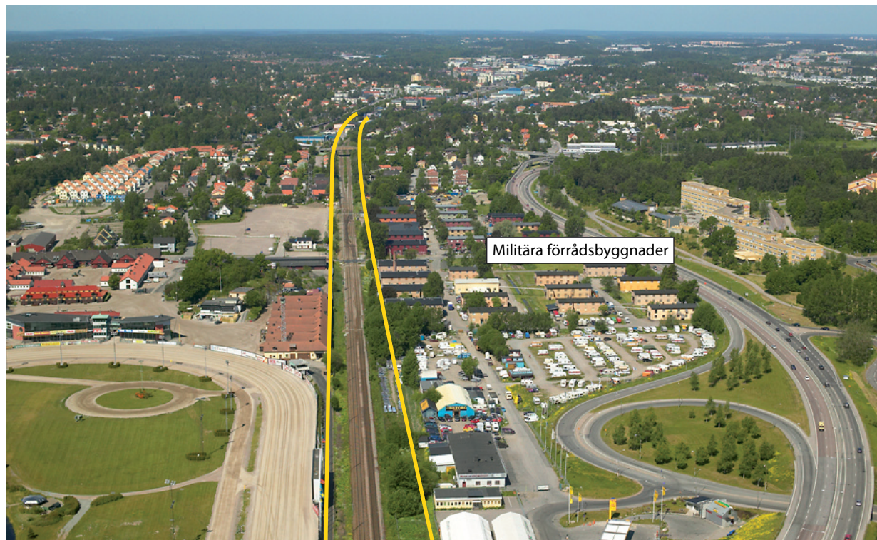
De militära förrådsbyggnaderna från 1940-talet vid Solvalla kan påverkas genom rivning av enstaka byggnader vid en breddning av spåret i befintlig korridor.
