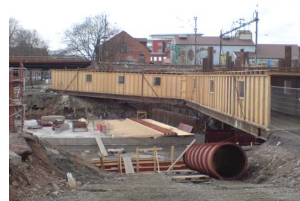
Exempel från Uppsala på tillfällig lösning för gång och cykeltrafik under byggtiden.
