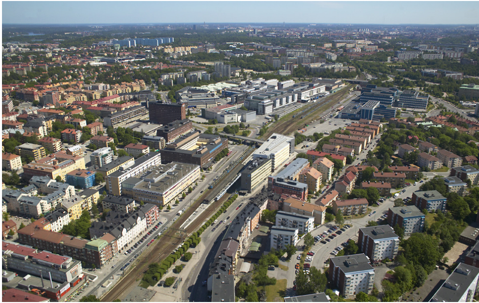
Sundbybergs station sett norrifrån mot Solna och Huvudsta.
