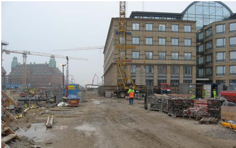
I Sundbyberg kommer byggandet att ske i stadsmiljö (bild från Citytunneln i Malmö).
