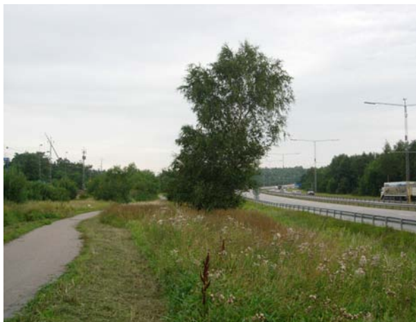
Gång- och cykelväg mellan järnväg och väg E18 vid Barkarby.
