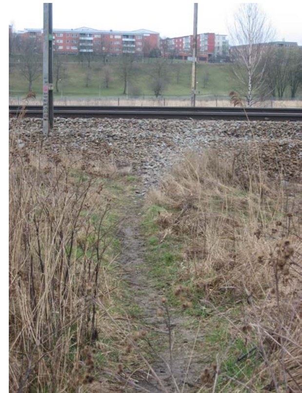
Stig fram till plats där personer genar mellan Garpenbergsgatan i Spånga och Tensta. Stängsel saknas på ena sidan järnvägen. Foto: ÅF.
