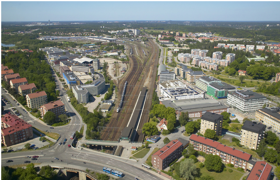
Solna station söderifrån.
