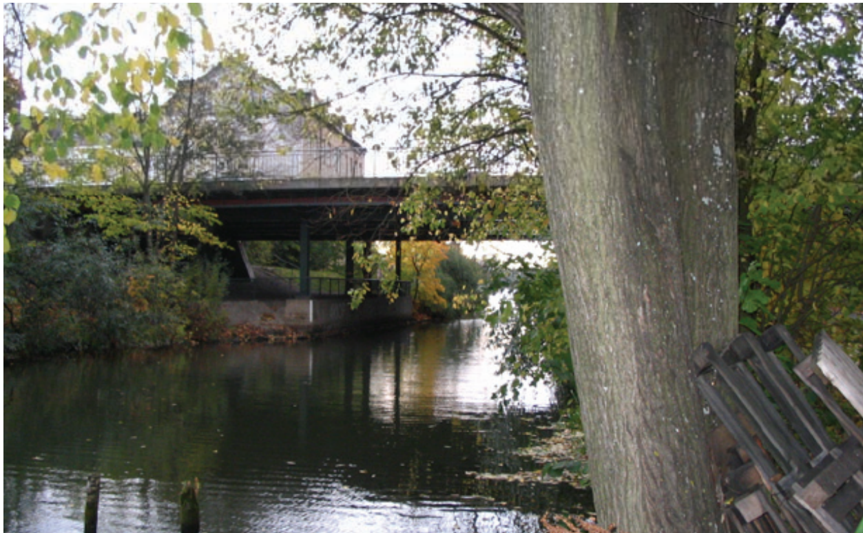
Sträckan från Barkarby till strax söder om Jakobsberg går nära Ballstaån och kan innebära risker för översvämning eller skred för järnvägen, vilket måste klarläggas i kommande projektering. Foto: DHI.
