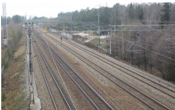
Fyrspårsjärnväg på Ostkustbanan vid Silverdal. Foto: ÅF.
