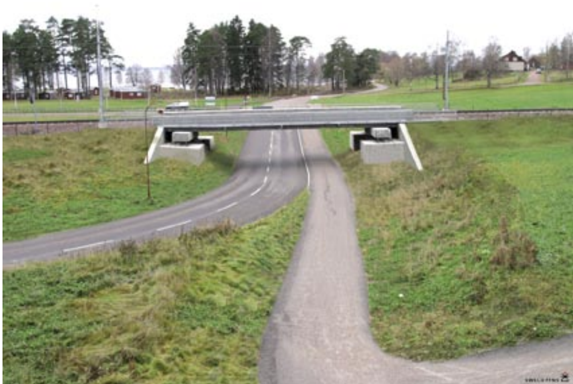
Med en annan utformning av stödmurarna kan man få lutningar som gräset klarar. Brons uttrycksfulla konstruktion kan då framträda i samspel med landskapet.
