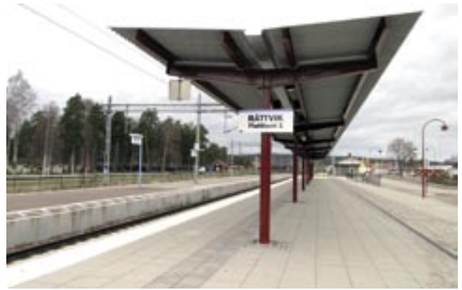
I den enkla och sakliga utformningen av plattform och skärmtak framstår gatstensytan vid pelarnas markanslutning som slarvig.
