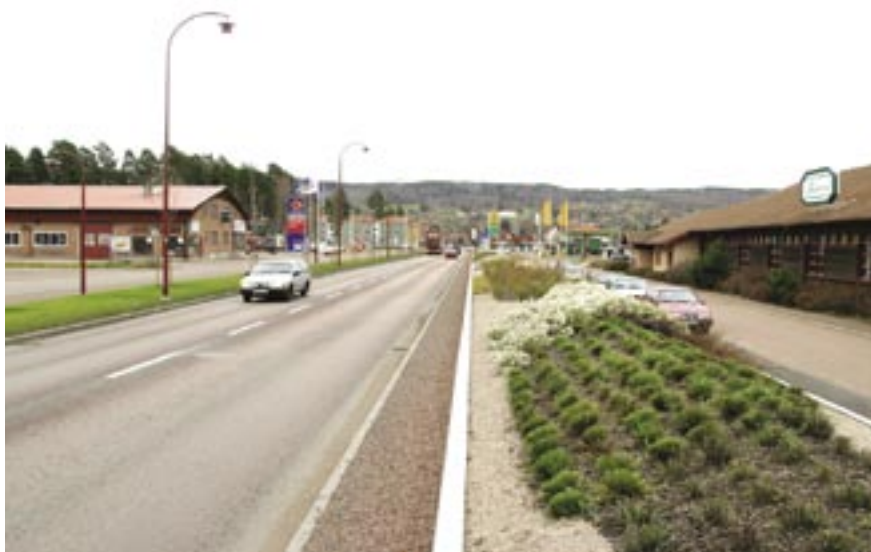
Blomlådor som avskiljare mellan riksvägen och den lokala vägen i industriområdet.
