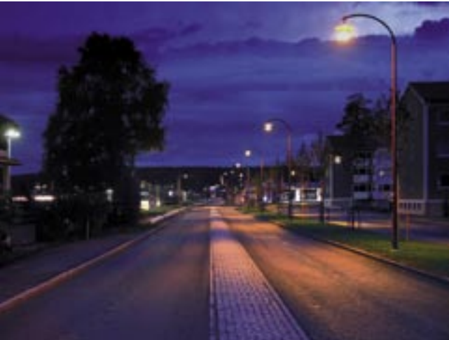
Centrala Rättvik efter: Lägre ljuspunktshöjd och smalare vägprofil signalerar lägre fart i dag.
