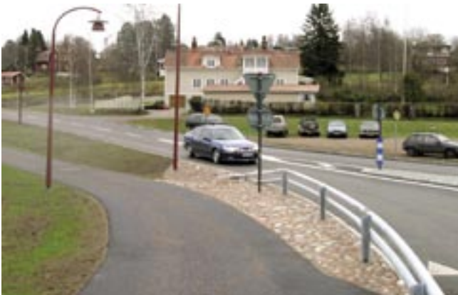
Fältstensytan uppfattas som både obegriplig och ful, likaså räcket avslutning rakt ner i backen
