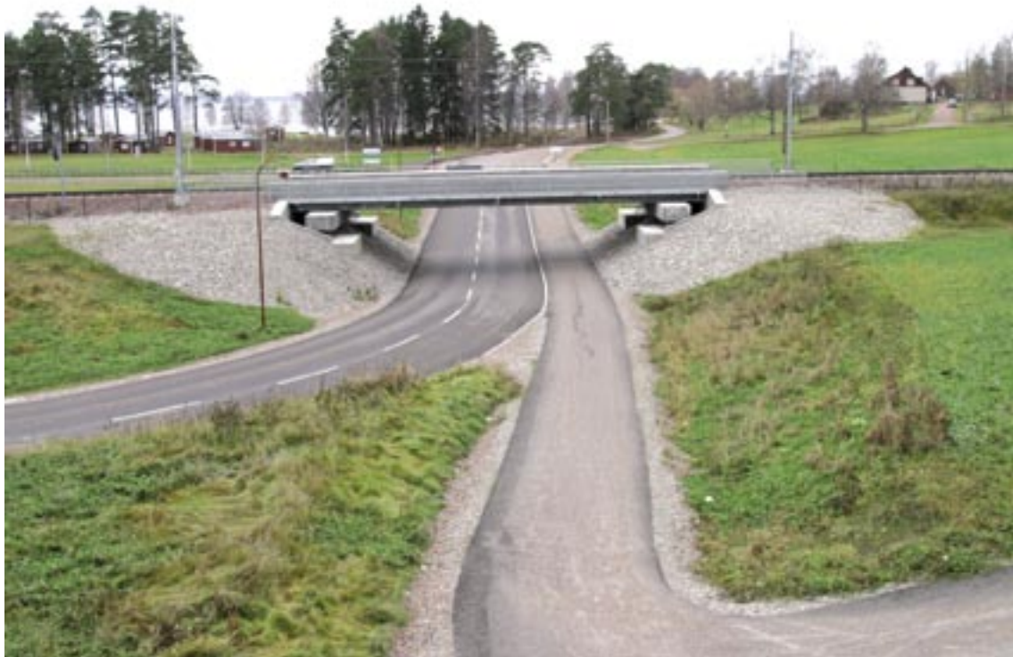
Dagens bro präglas i hög grad av de slarvigt formade grusytorna runt landfästena. Mötet mellan bron och det omgivande landskapet är ofärdigt och sårigt.
