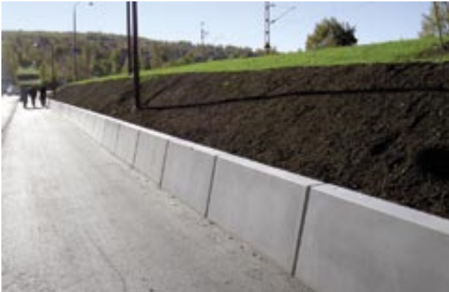
En prydlig stödmur...
