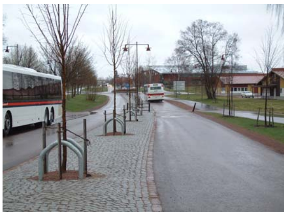
Figur 8 Röda vägen efter ombyggnad. Kantsten på höger sida i färdriktning saknas. Foto: Monica Lundin, TFK.
