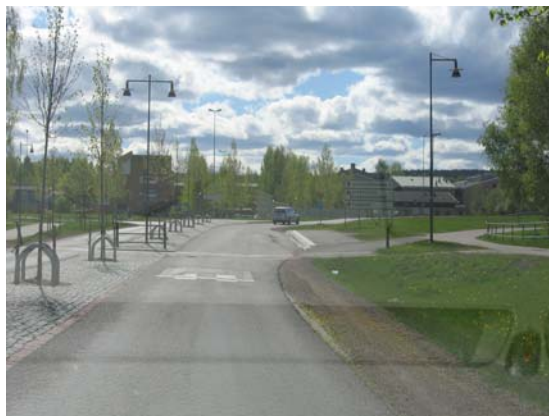
Figur 8 Röda vägen efter ombyggnad. Kantsten på höger sida i färdriktning saknas. Foto: Monica Lundin, TFK.
