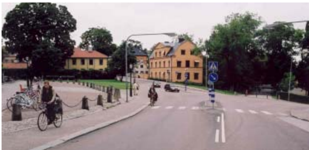
Figur 2.12 Korsningen Dag Hammarskjölds väg, Övre Slottsgatan och Drottninggatan vid föresituationen år 2001 sett från Dag H:s väg mot Övre Slottsgatans norra anslutning. Foto: Vägverket region Mälardalen.
