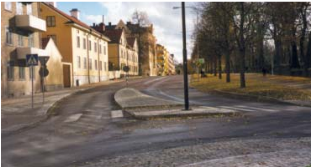
Figur 2.20 Kyrkogatans södra anslutning i korsningen med S:t Johannesgatan vid eftersituationen år 2002. Foto: VTI.
