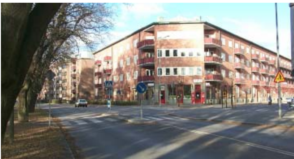
Figur 2.3 Korsningen mellan Strandgatan och Noachsgatan. Bilden tagen vid eftersituationen år 2002 från Strandgatan med Noachsgatans anslutning till höger. Foto: VTI.
