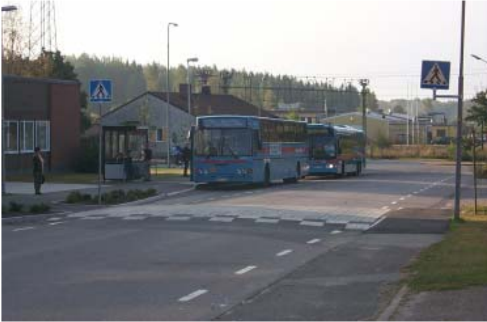
Figur 2.10 Skolgatan i riktning mot Norra Bangatan vid eftersituationen år 2002 med den anlagda upphöjningen i förgrunden. Foto: VTI.
