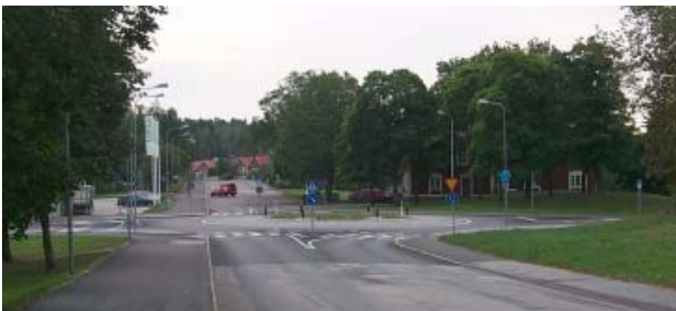
Figur 2.5 Korsningen mellan Floravägen och Norrbyvägen vid eftersituationen år 2002. Bilden tagen från Norrbyvägens norra anslutning. Foto: VTI.
